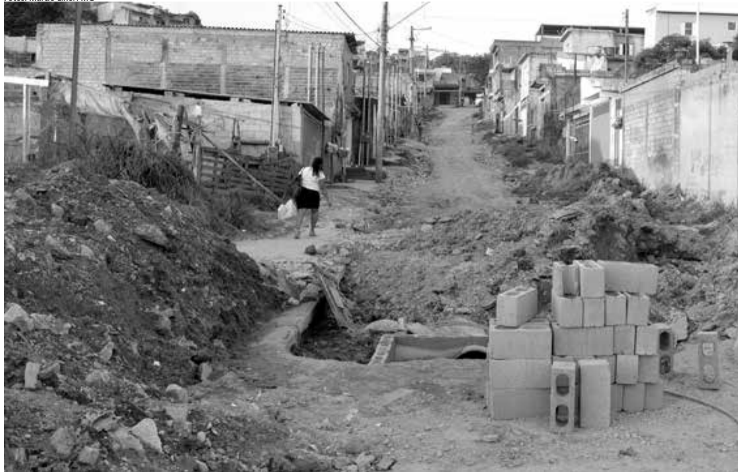
A rua Sueli Aparecida Perroni, na Vila Rica, é uma das 15 vias do bairro que receberão intervenções e melhorias na infraestrutura
