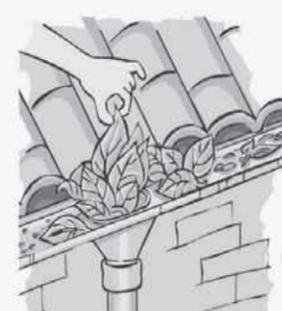
**TIRE TUDO QUE POSSA IMPEDIR A ÁGUA DE CORRER PELA CALHA**
