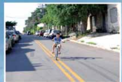
Pavimentação e recapeamento
