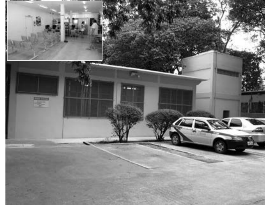
Instalação ganhou nova rede elétrica, torneiras, sanitários adaptados, entre outras melhorias
