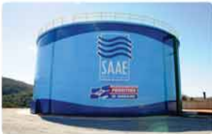
5 novos reservatórios de água
