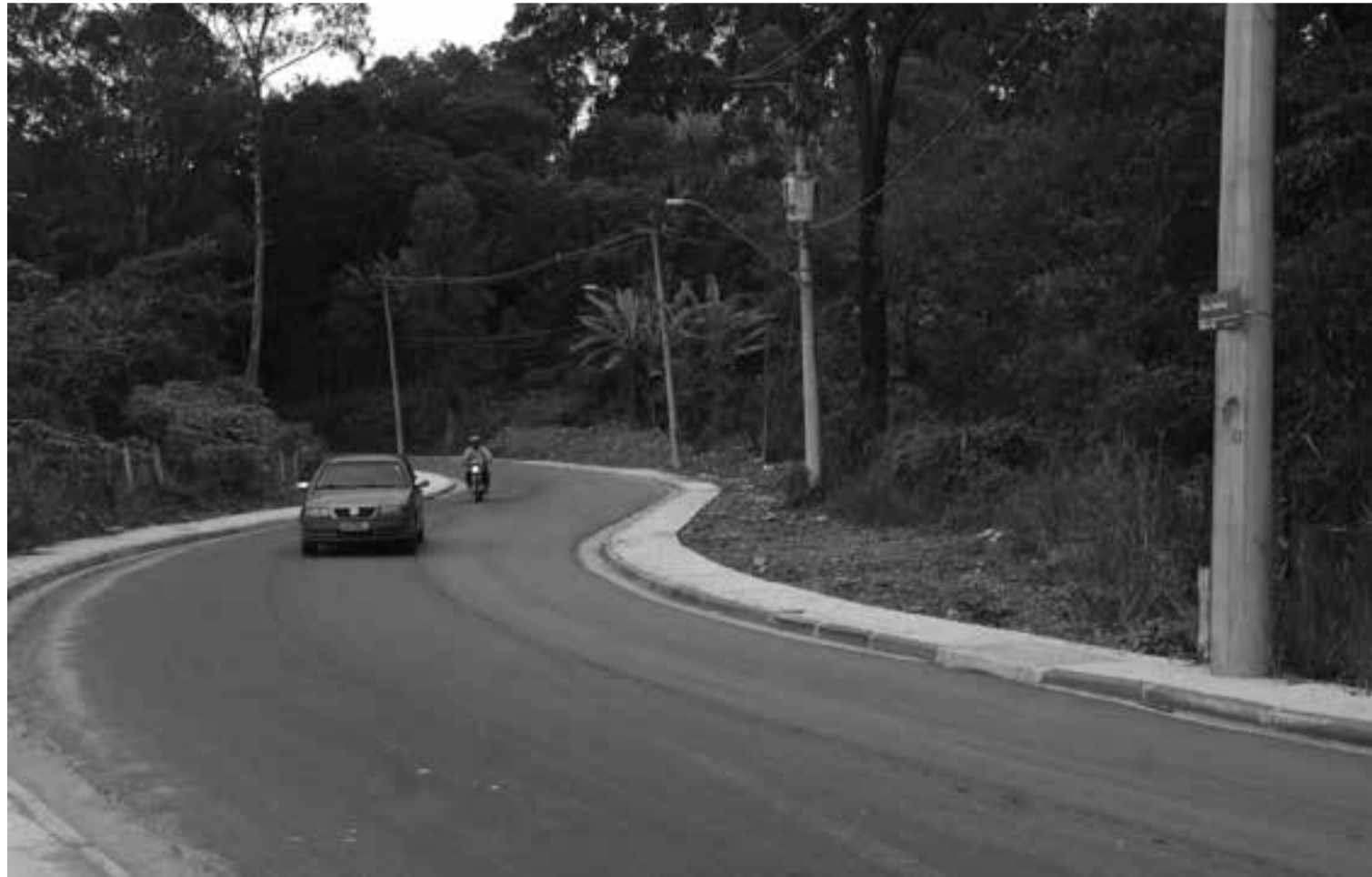
Implantação de drenagem, guias, sarjetas e passeio em concreto na rua Cedibra beneficia moradores da Vila União e Parque Primavera
