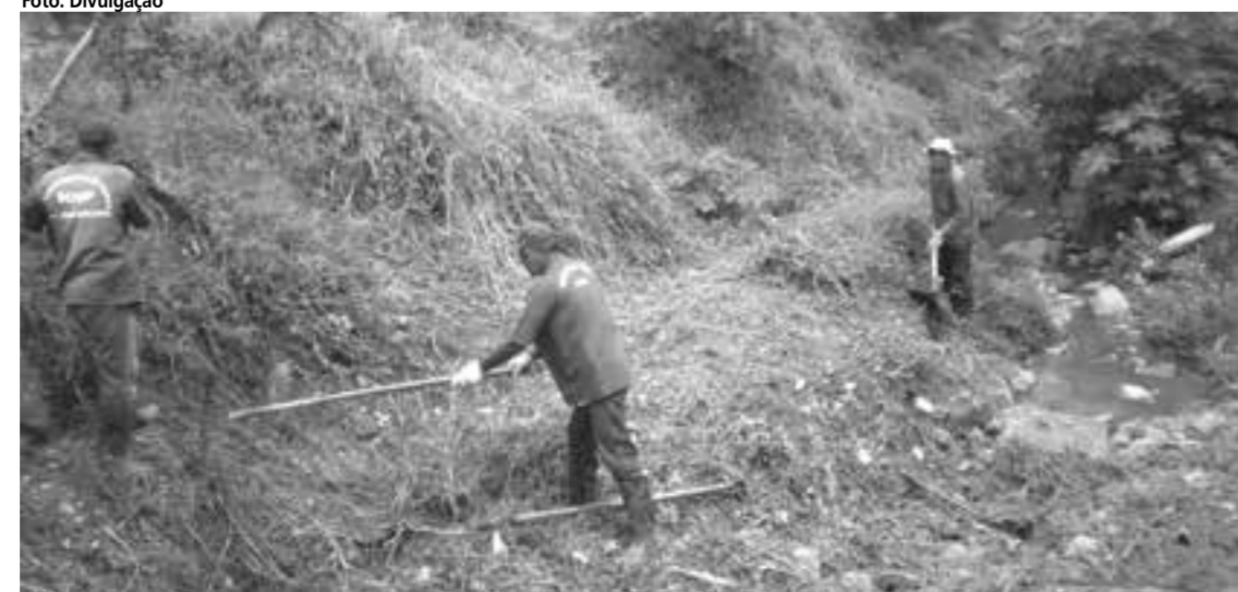
Ações das Regionais, como o trabalho de limpeza e roçagem, beneficiam diariamente toda a cidade
