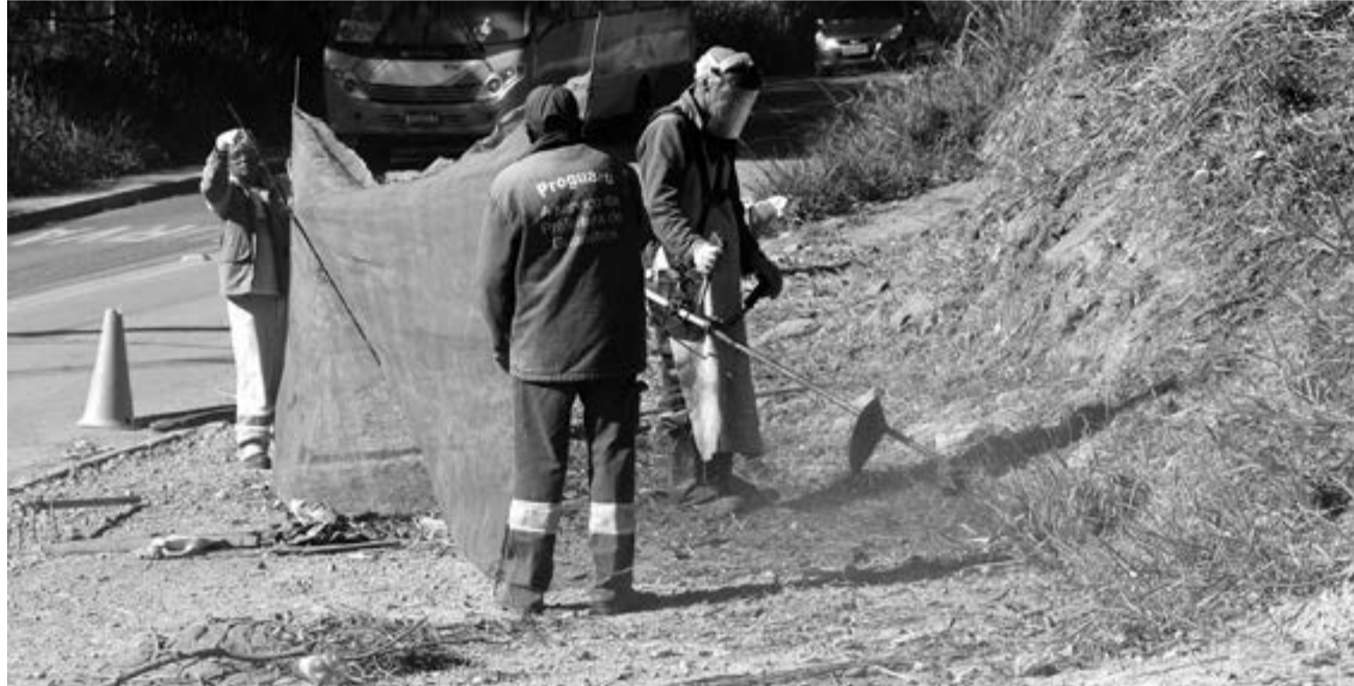
As equipes de manutenção das regionais e secretarias da Prefeitura, da Proguaru e do Saae em ação na região do Cabuçu
