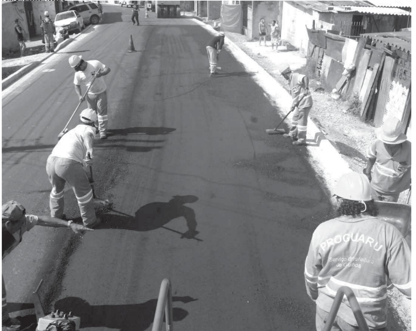
► Obras incluíram elevação média de 70 centímetros do piso e colocação de 30 tubos de drenagem para escoar a água
