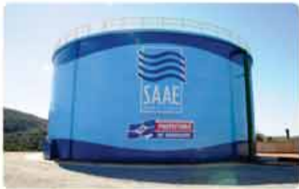
5 novos reservatórios de água
