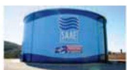
5 novos reservatórios de água
