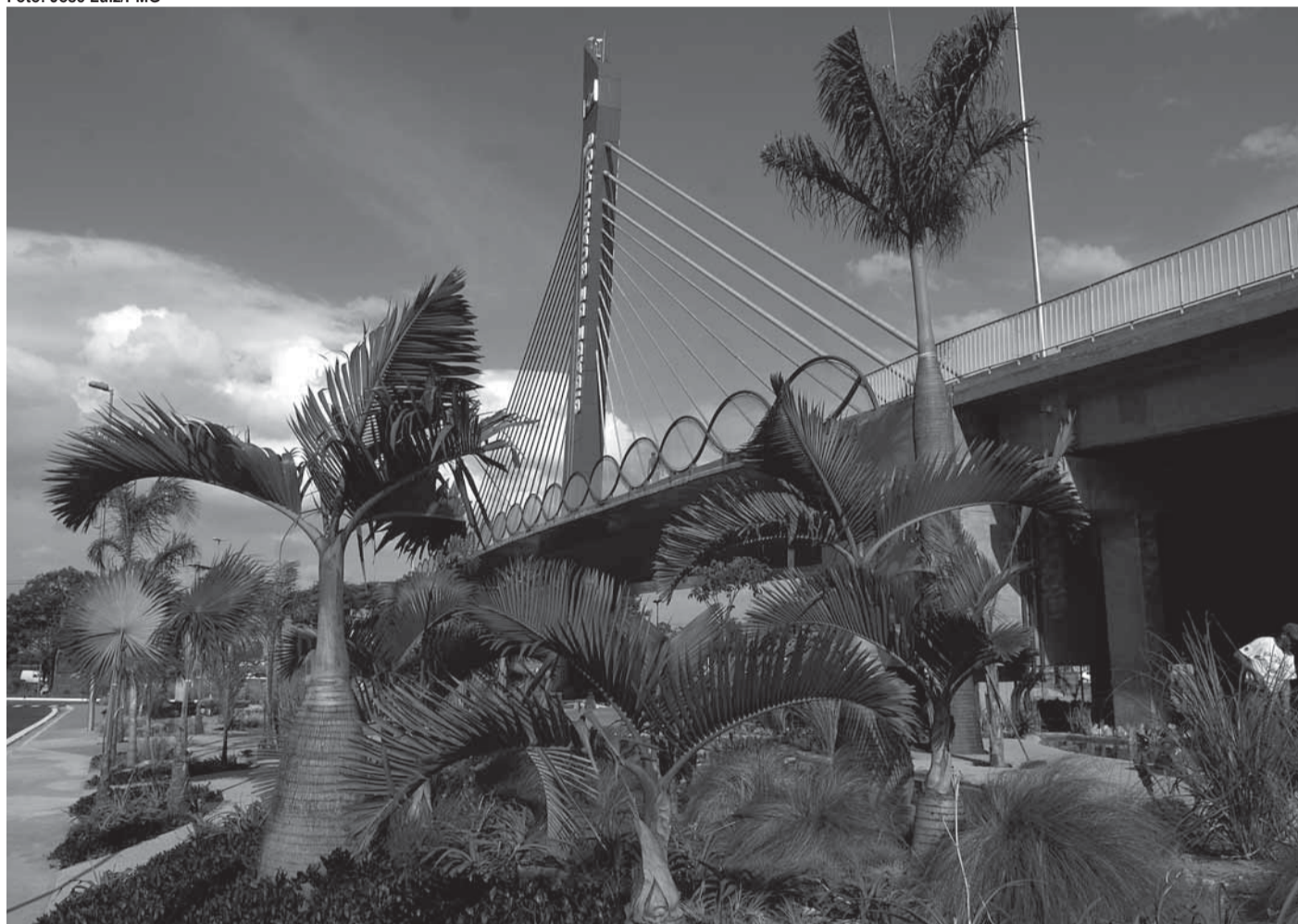
▶ Obra envolveu as secretarias de Serviços Públicos e Meio Ambiente e beneficiados do Bolsa-Auxílio ao Desempregado
