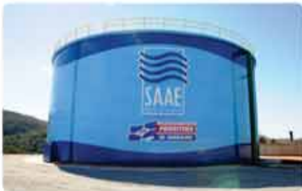
5 novos reservatórios de água
