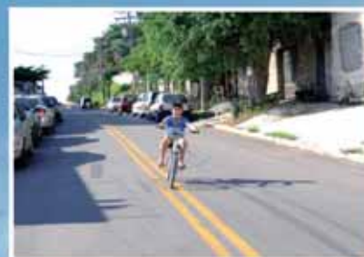
Pavimentação e recapeamento
