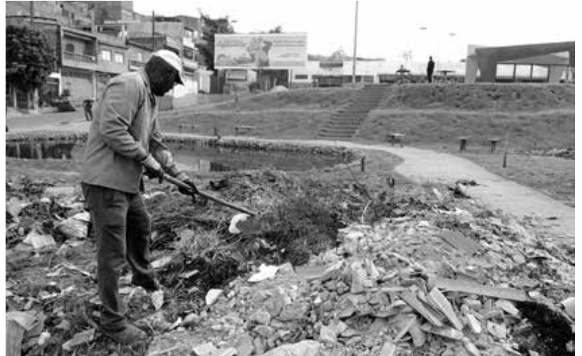
Parte do entulho é enviada para a Usina de Reciclagem da Proguaru, para ser usada em pavimentação
