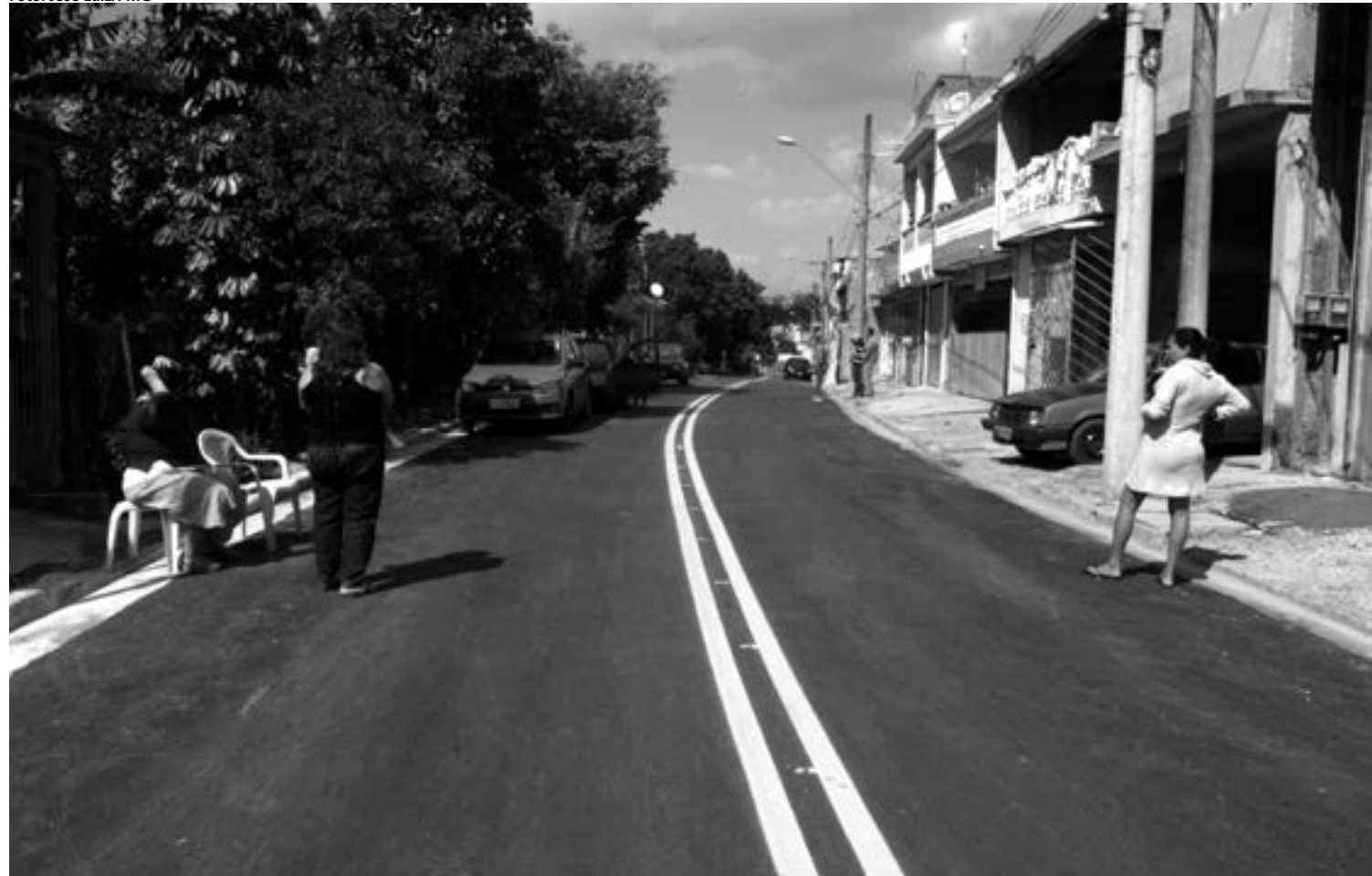
A rua Ghunter Stahl é uma das vias beneficiadas na região, recebendo pavimentação, guias, sarjetas e obras de infraestrutura
