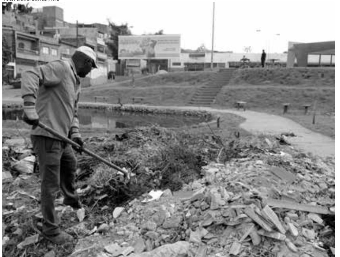
Parte do material recolhido pelo Delurb é reaproveitada e utilizada em obras de pavimentação
